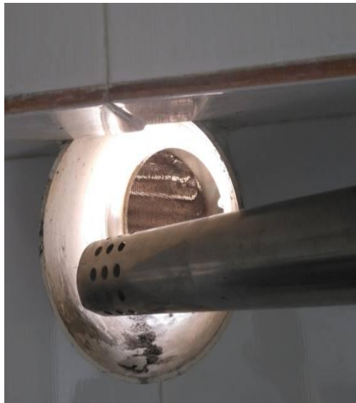
浴室内排气口及排烟管的位置关系
